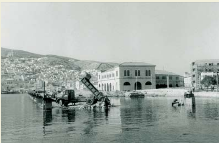
Έργα κατασκευής προβλήτας στη περιοχή Τελωνείου τη δεκαετία 1960 - 1970. Αρχείο: Δημητρίου Ν. Χάλαρη
