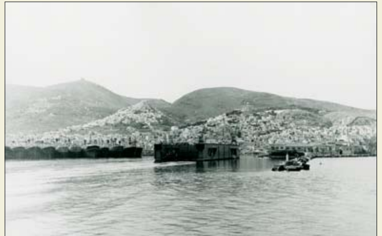
Φορτηγά δεμένα λόγω της κρίσης στο λιμάνι και η πλωτή δεξαμενή. Τέλος δεκαετίας 1950.
